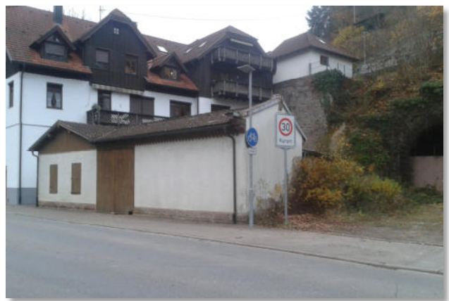
Der alte Lagerschuppen vor dem Abriss
