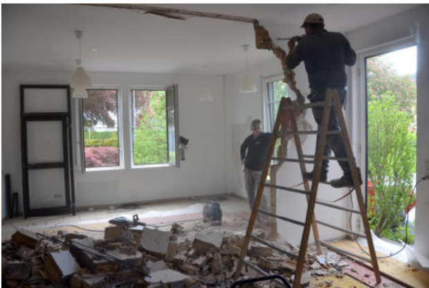
Die mitunter lauten Umbauarbeiten während des Regelbetriebs...
