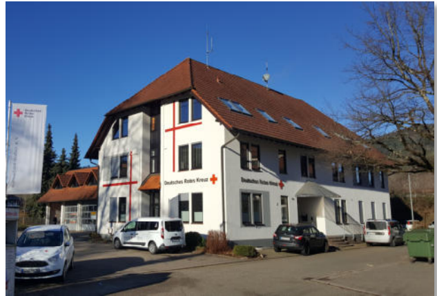
Das renovierte DRK-Gebäude erstrahlt in neuem Glanz
