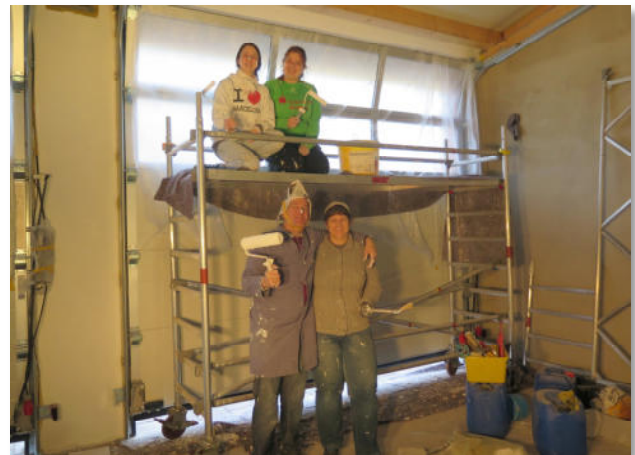
Fleißige Helfer beim Innenausbau
